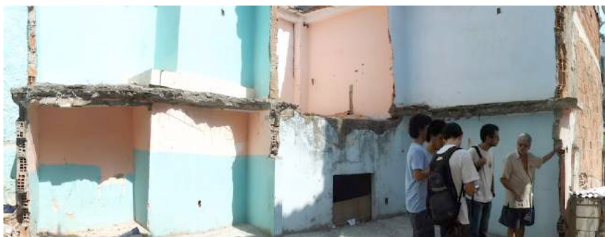
Figura 10: Casas demolidas em Indiana. Fonte: Acervo Abricó/EMAU/UFRJ.
