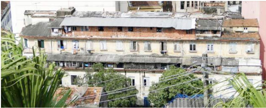
Figura 47: Fachada do edifício Colonial modificada pelos moradores Fonte: Thiago Lamenha
